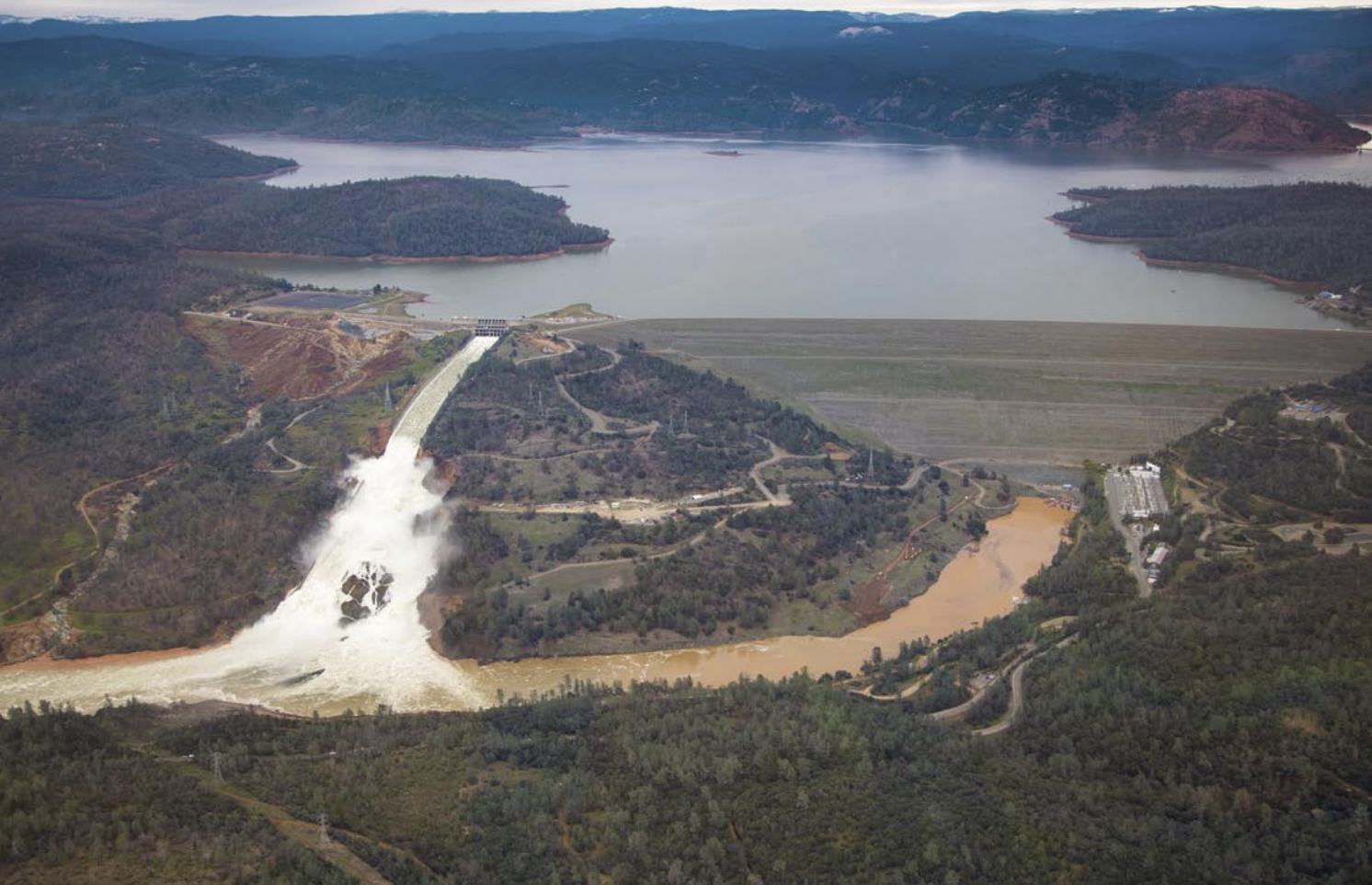
Blick auf den Damm am 15. Februar. Links neben der Abflussrinne die geschlossene Notfallrinne
