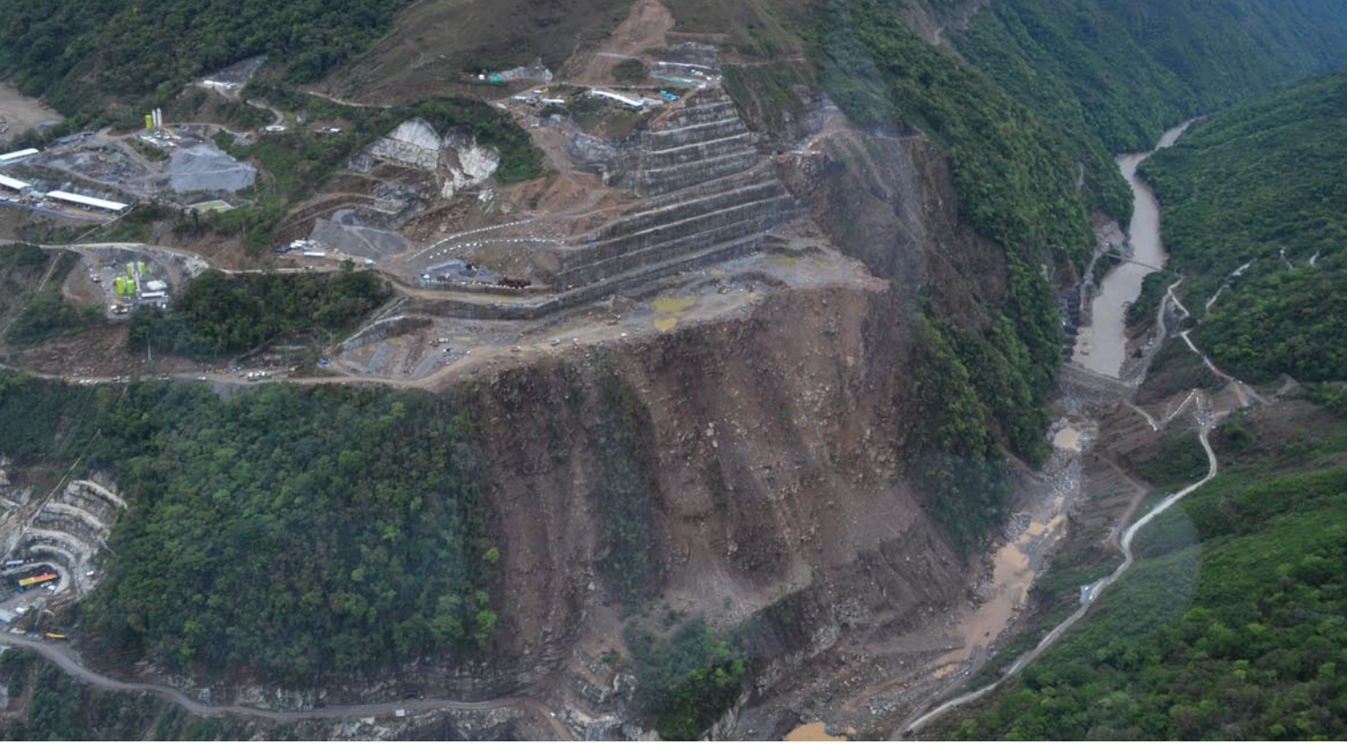
Die Baustelle des Damms zu Beginn der Bauarbeiten
