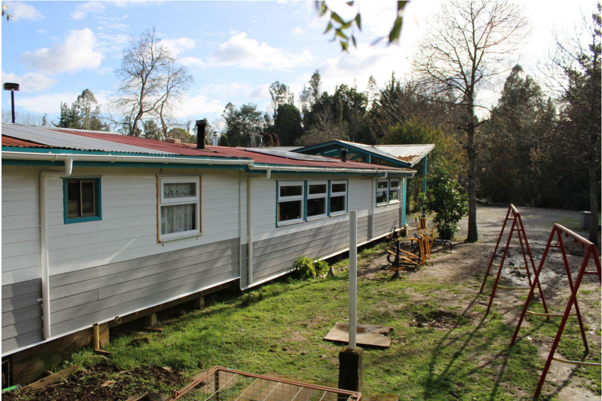
Abbildung 12: Neue Solarpaneele auf dem Dach der Schule Fundo Maquehue.
