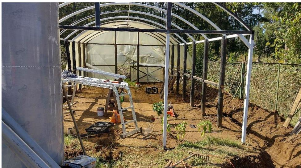
Schließlich wurde das Gewächshaus der Schule umgebaut: Die Holzstützen, die bereits Anzeichen von Verfall aufwiesen, wurden durch Metallpfeiler ersetzt, und das Nylondach wurde durch Polycarbonatplatten ersetzt, die eine ungefähre Haltbarkeit von 10 Jahren gewährleisten, was die Nutzungsdauer von Nylon, die nur 2 Jahre betrug, bei weitem übertrifft.
